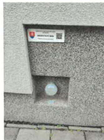
Obr. 3 Príklady vynechania výrezu: Geodetický bod môže ostať na fasáde priznaný alebo zakrytý plastovou chráničkou, prípadne kovovou mriežkou
