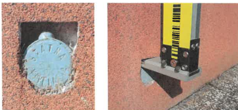
Obr. 2 Vhodne upravená fasáda okolo nivelačného bodu pri geodetickom meraní
